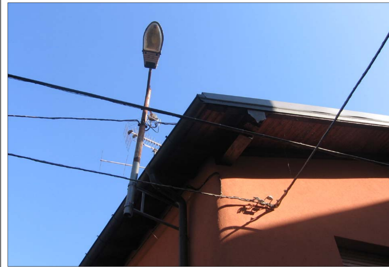
FOTO N. 1 - PARTICOLARE LAMPADE ESISTENTI DA SOSTITUIRE
